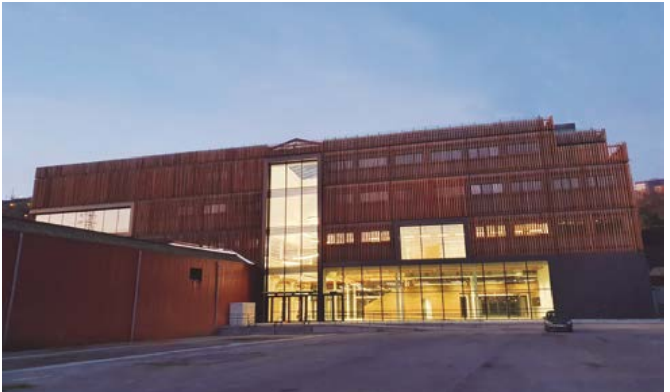
Bâtiment Beta 2 (Phase II) à Zorrotzaurre à Bilbao (Espagne)
