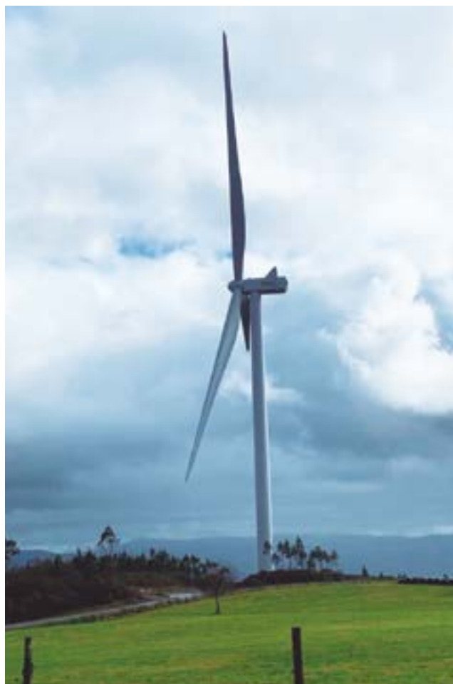
Parcs Éoliens pour Norvento Lugo (Espagne)
