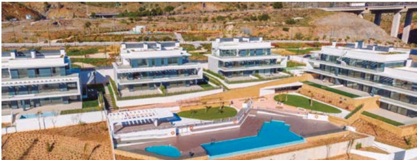
Immeuble Résidentiel La Escala de Valdebebas, Madrid (Espagne)
