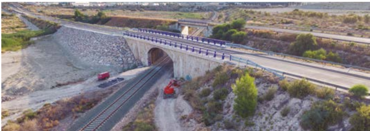
Réparation du pont sur la voie ferrée sur la N-301 à Lorquí, Murcie (Espagne)
