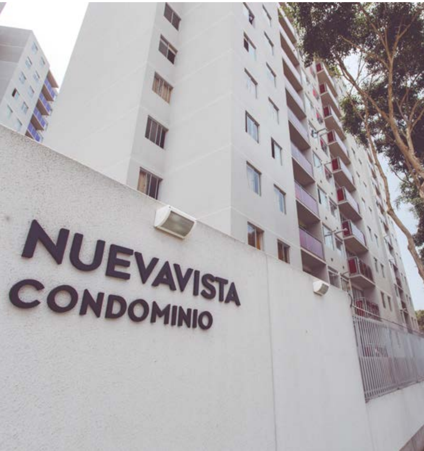
Condominium Nuevavista dans le quartier Bellavista de Callao - 1 104 logements -, Lima (Pérou)
