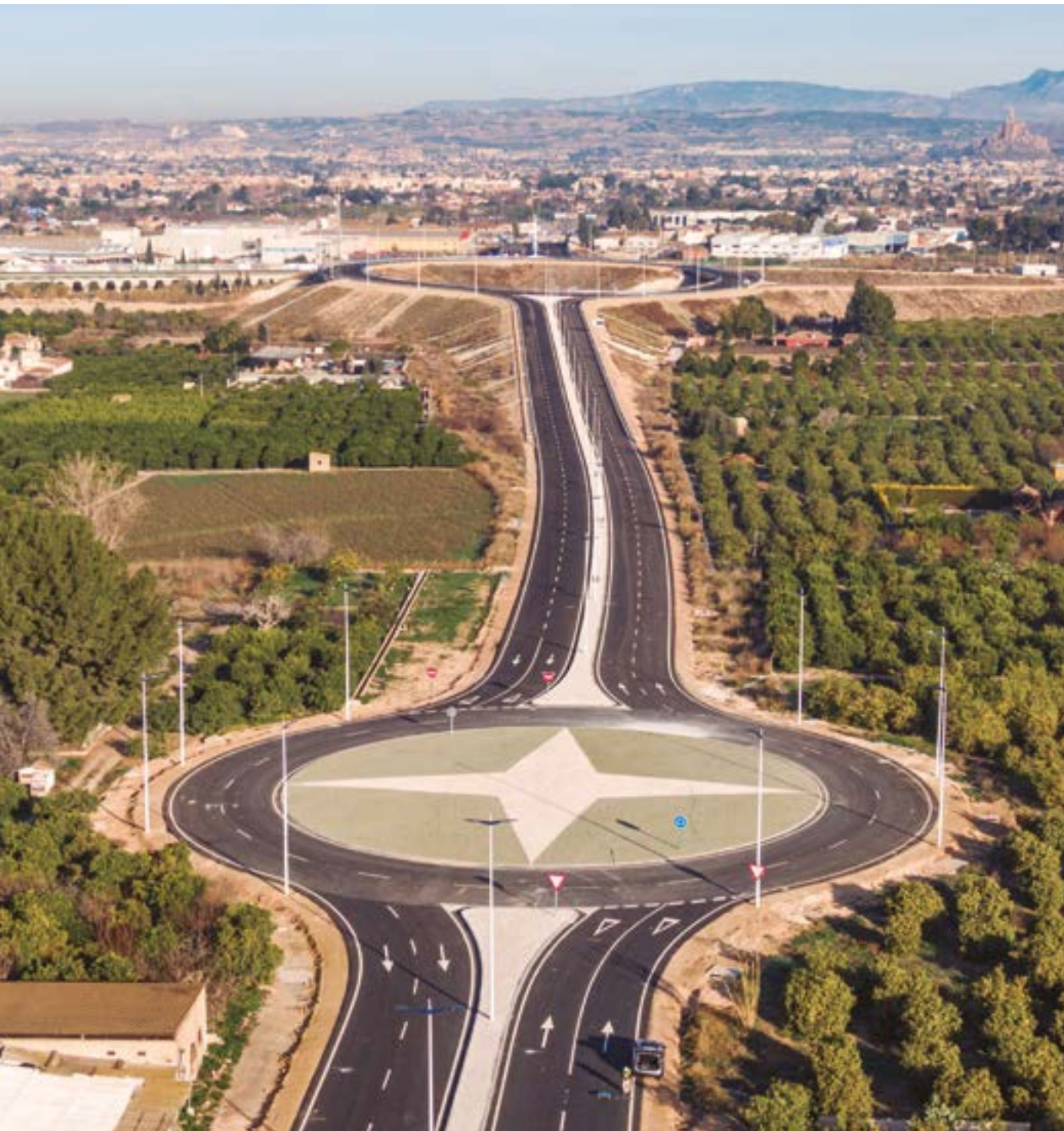
Tronçon de l'autoroute Reguerón du périphérique MU-30 à Murcie (Espagne)
