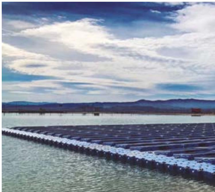
Pompage solaire flottant sur radeau et deux pompes souterraines pour l'auto-consommation dans la communauté d'irrigation de Llíria, Valence (Espagne)
